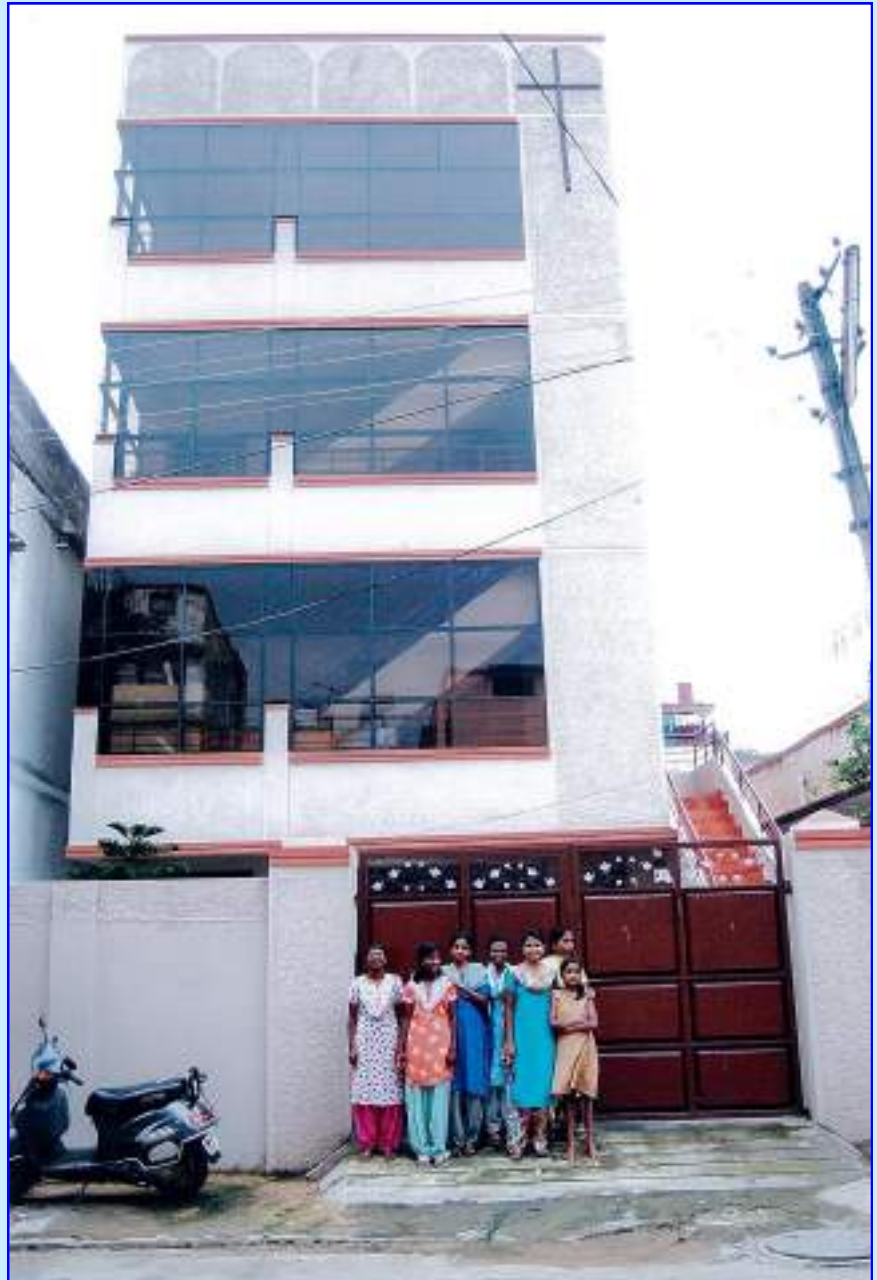
Vista del nuovo Edificio a tre piani con pianterreno
